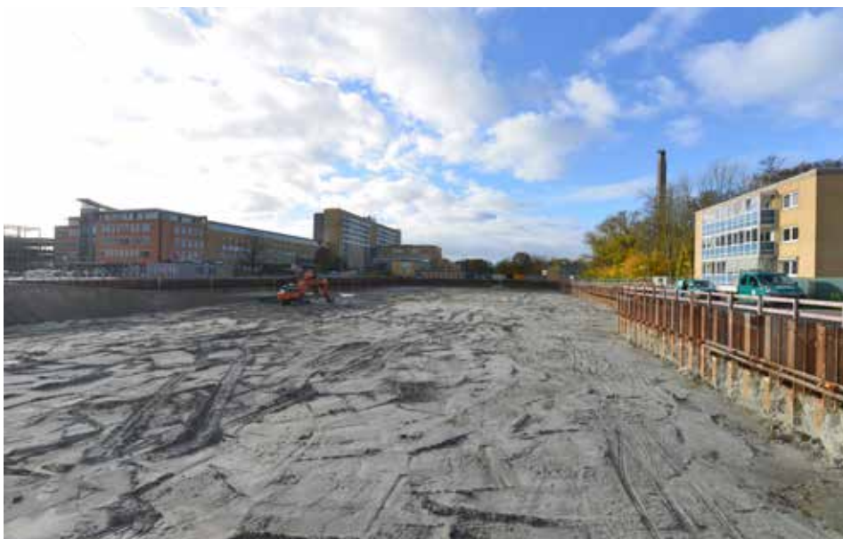
Aktuell beträgt die Höhe der ausgehobenen Baugrube -2,50 m NHN.
